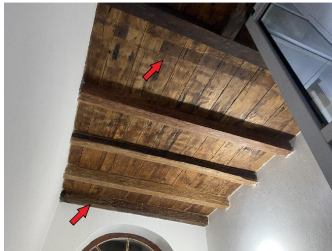
Foto 02 – Assoalho em madeira a ser inspecionado e recuperado.
