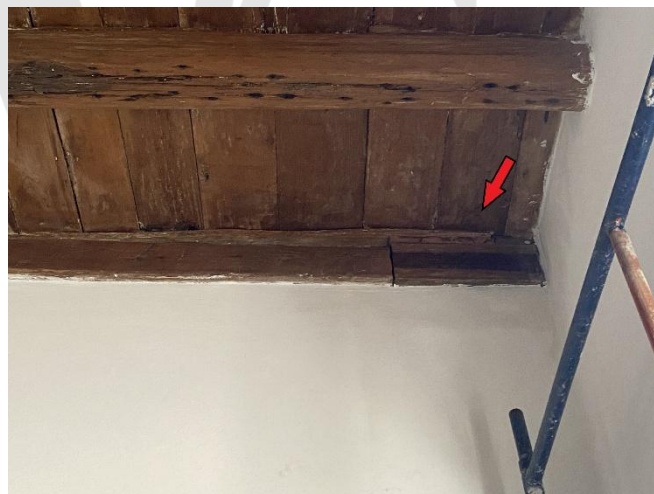
Foto 04 – Assoalho em madeira a ser inspecionado e recuperado.
