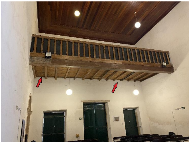
Foto 01 – Assoalho em madeira a ser inspecionado e recuperado.
